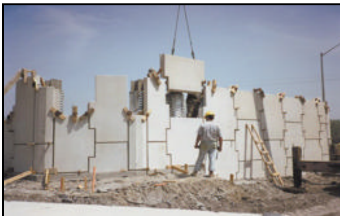
شکل ۱۲-۴- اجرای دیوار خاک مسلح با نمای بتنی
