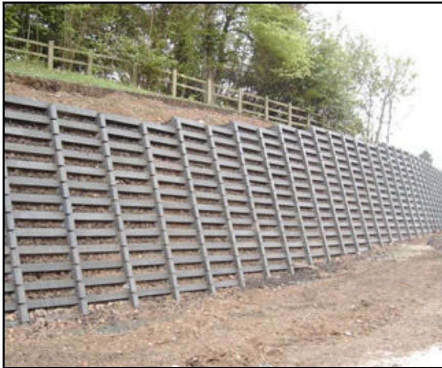
شکل ۱۱-۸ - نمونه‌ای از دیوار حائل صندوقه‌ای اجرا شده
